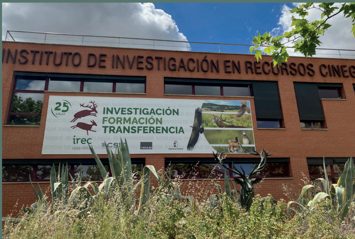
Edificio del IREC / IREC building
